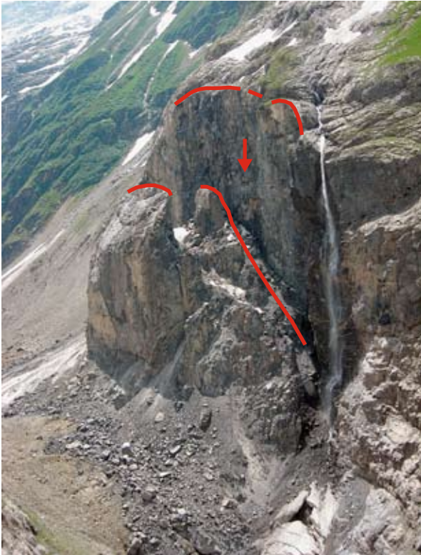
Abbildung 4: Neben dem zum Unteren Grindelwaldgletscher stürzenden Bach der Schlosslouwina in der Ostflanke der Eiger-Hörnli hat sich eine rund 200 m hohe und 250 m breite Felspartie vom Berg gelöst, in zwei Pakete aufgeteilt und um insgesamt rund 50 m gesenkt. Aufnahme vom 24. Juni 2008. Die Spalte war im Juni 2006 von Hansruedi Burgener, Wirt auf der Bäregg, entdeckt worden. Die Vorgänge wurden in der Folge vom Grindelwaldner Rettungschef Kurt Amacher und vom Geologen Hansrudolf Keusen genau verfolgt. Man rechnete zuerst mit einem nahe bevorstehenden grossen Sturz der auf rund 2 Millionen m 3 geschätzten Felsmasse. Es stürzte jedoch im Juli 2006 nur etwa ein Fünftel davon auf den Gletscher. Der Hauptteil löste sich zwar zunehmend vom Hang und teilte sich in zwei Pakete auf, stürzte aber nicht, sondern sank mit seinem Fuss langsam immer tiefer
